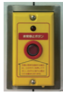
非常停止ボタン
